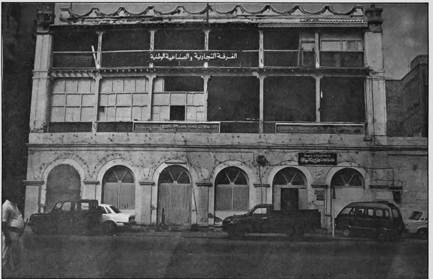
La maison Rimbaud, avant travaux (photo. P. Maréchaux)
