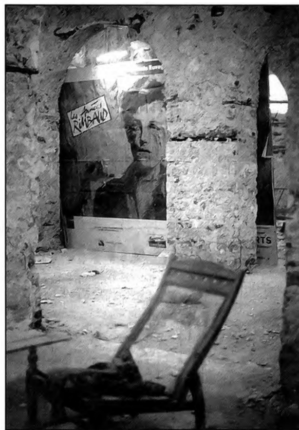
La grande pièce du rez-de-chaussée a été mise à nu. Arthur veille sur les travaux.
